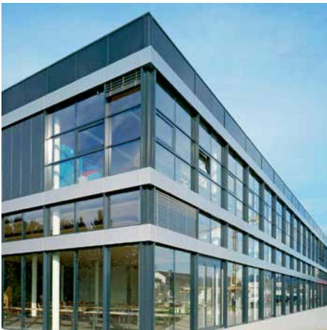
Pfosten/Riegel-Konstruktion in Stahl/Aluminium Werkstätte der Stiftung für Behinderte, Lenzburg
