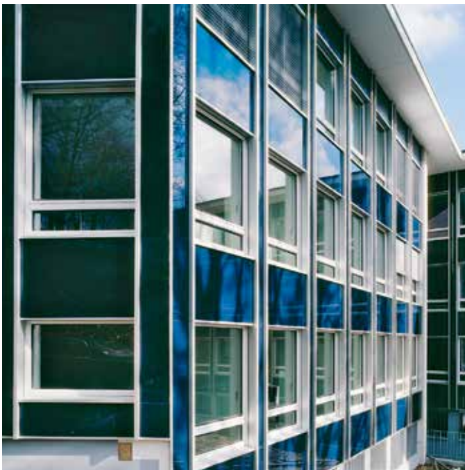
Fassaden-Renovation, Holz/Metall-Fenster, Glasbrüstungen Amtshaus Parkring, Zürich
