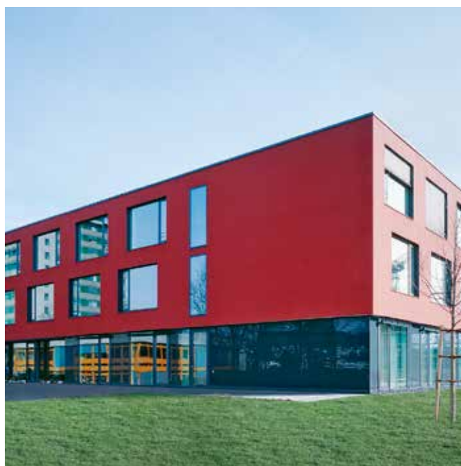
Pfosten/Riegel-Konstruktion in Aluminium Pflegezentrum Baar
