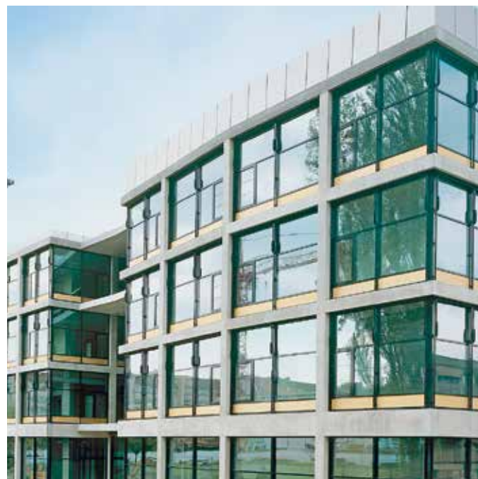
Pfosten/Riegel-Konstruktion in Stahl/Aluminium, Minergiegebäude Schulhaus Albisriederplatz, Zürich
