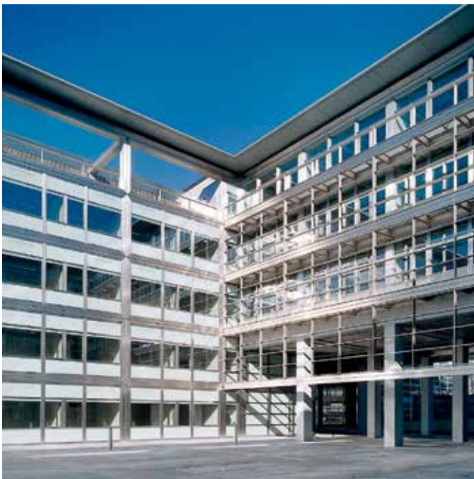
Elementfassade mit Verbundfenstern und Verkleidung in CNS ETH Hönggerberg, Zürich
