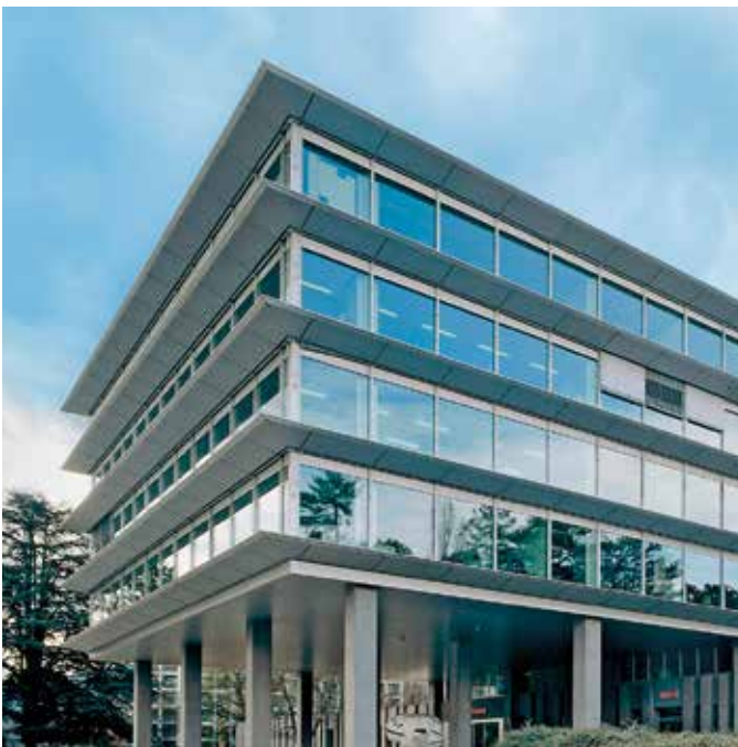
Fassaden-Renovation, Fensterelemente und Reinigungsbalkone Geschäftshaus Pittard, Genf
