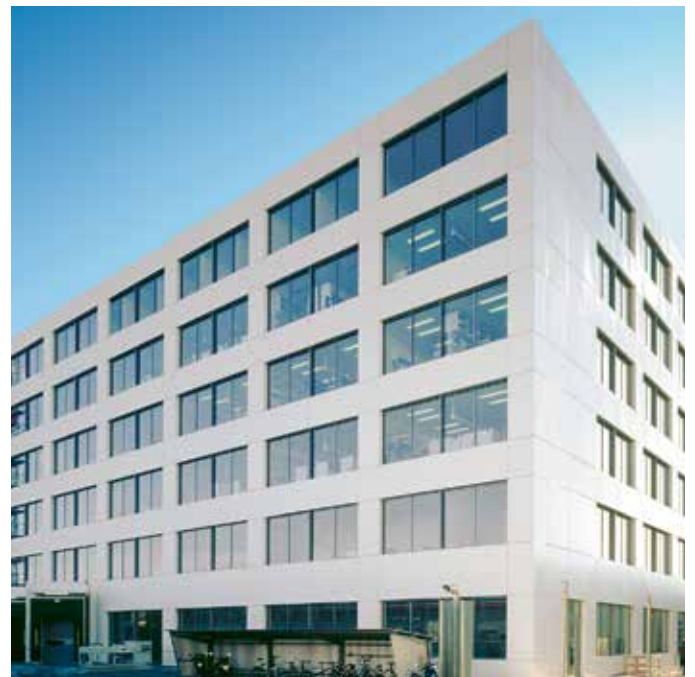
Pfosten/Riegel-Konstruktion und Blechverkleidungen Geschäftshaus Roche Diagnostics RDR, Rotkreuz
