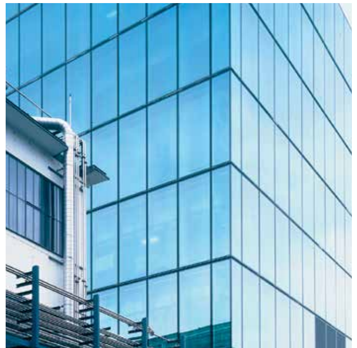
Grundkonstruktion in Stahl, Gläser mit SSG-Technik auf Aluminiumrahmen geklebt Produktionsgebäude Roche 95, Basel
