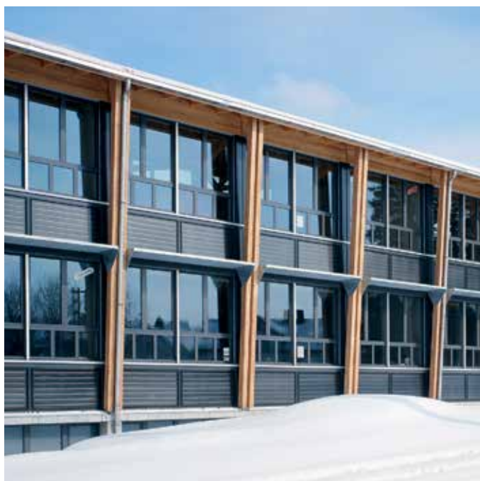
Holz/Metall-Fenster, Brüstungen mit Sonnenkollektoren Schulhaus Gais
