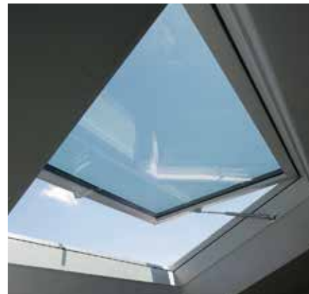
Blick von innen durch das geöffnete Dachfenster.
