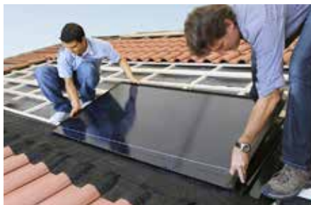
2 Insérez les panneaux de bas en haut et de droite à gauche.
