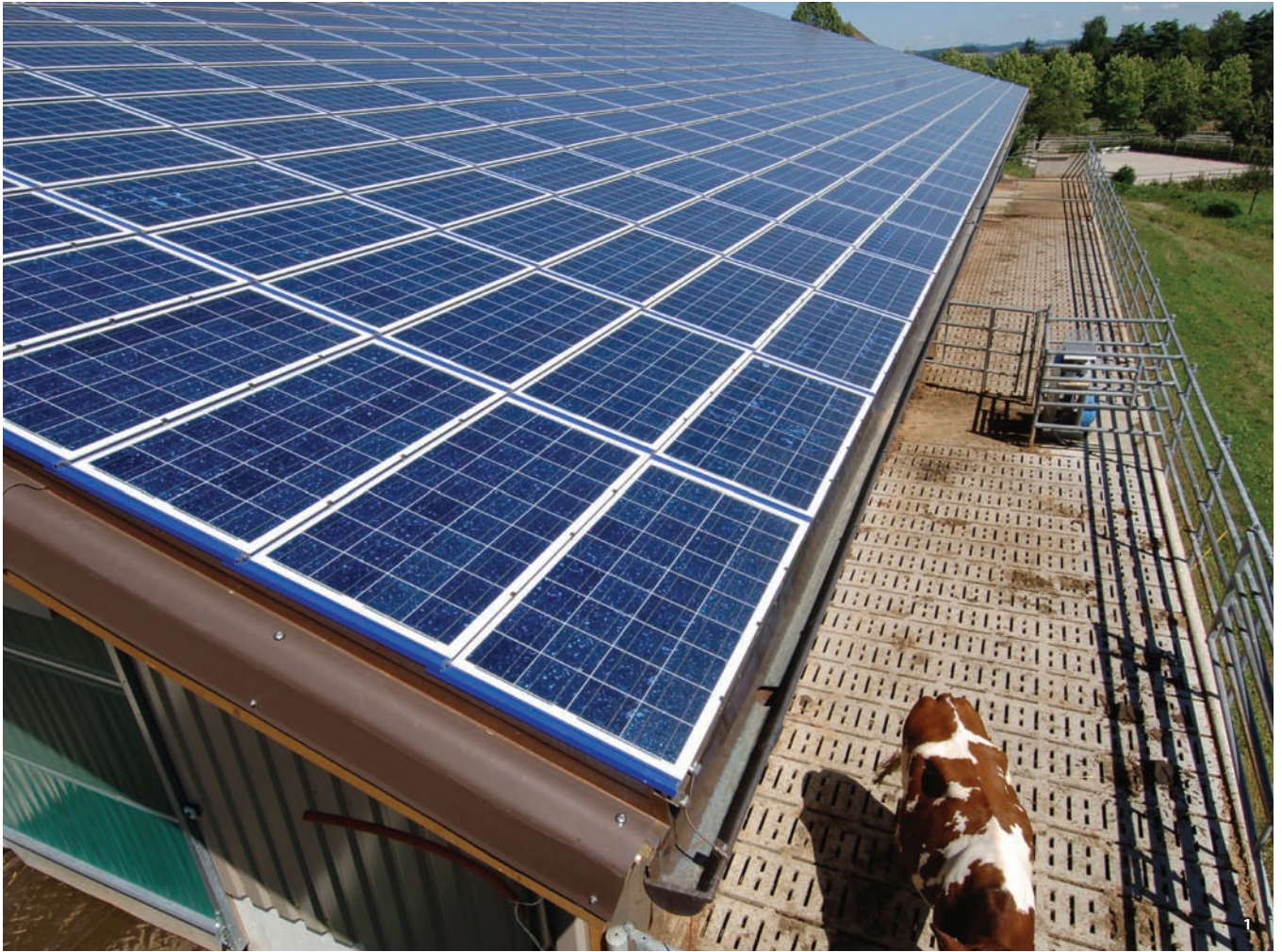
1: Toute la surface du toit de l'étable est couverte de panneaux photovoltaïques de 110 kWp. L'intégration, les finitions du toit et tous les détails sont exemplaires. 2: Depuis le sud, vue de l'ensemble du bâtiment, avec de la place pour environ 50 unités de gros bétail.
