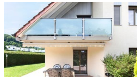
Einfamilienhaus in Langnau am Albis Balkongeländer
