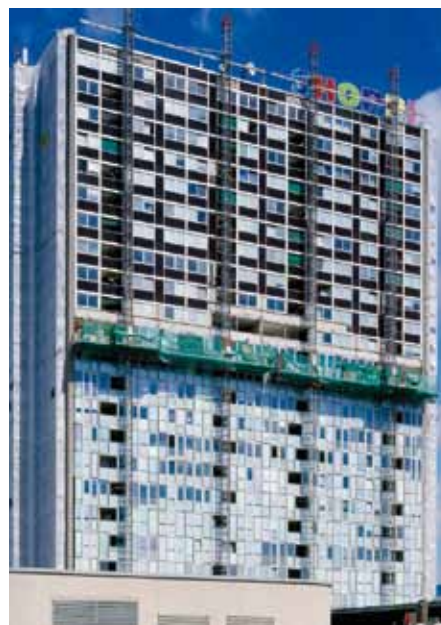
Tour du Shoppi à Spreitenbach: rénovation par étages avec plateformes sur mâts
