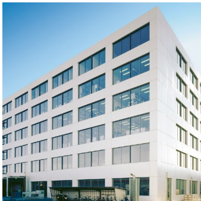
Construction poteaux/traverses et revêtements en tôle Siège de Roche Diagnostics RDR, Rotkreuz
