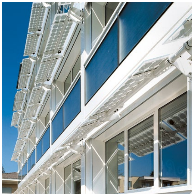
Fenêtres en aluminium, allèges avec capteurs solaires, pare-soleil avec cellules photovoltaïques Siège de l'association des hôteliers du Tessin, Lugano
