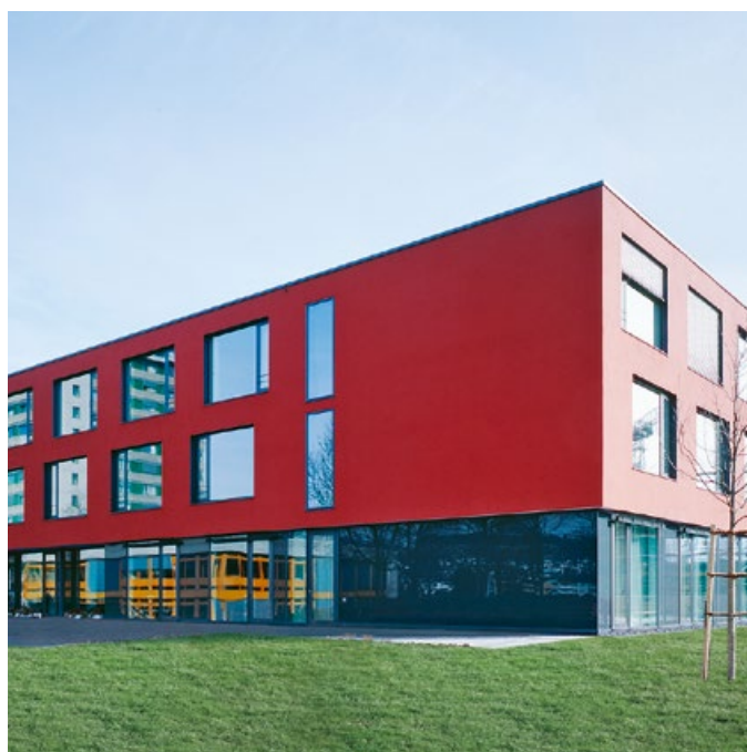
Construction poteaux/traverses en aluminium Centre de soins, Baar
