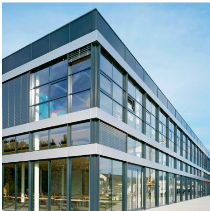
Construction poteaux/traverses en acier/aluminium Atelier de la fondation pour handicapés, Lenzbourg
