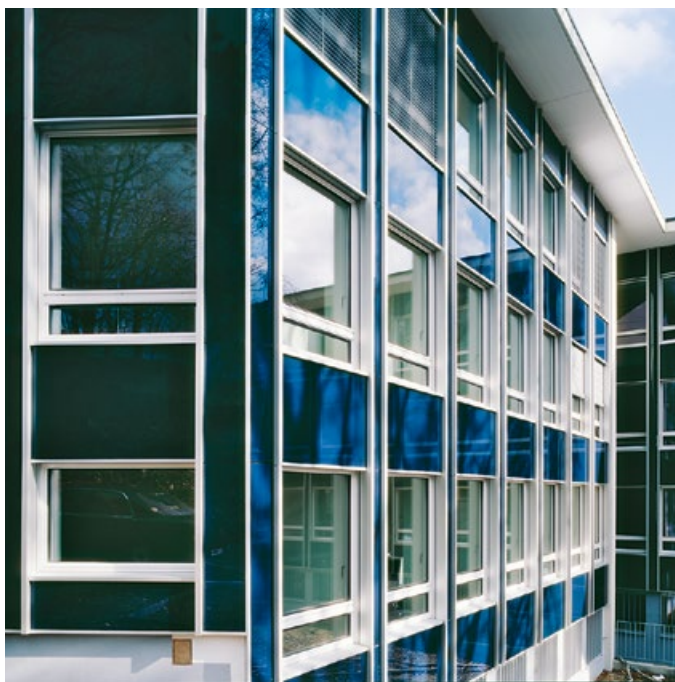
Rénovation de façade, fenêtres bois/métal, allèges vitrées Maison de commune Parkring, Zurich
