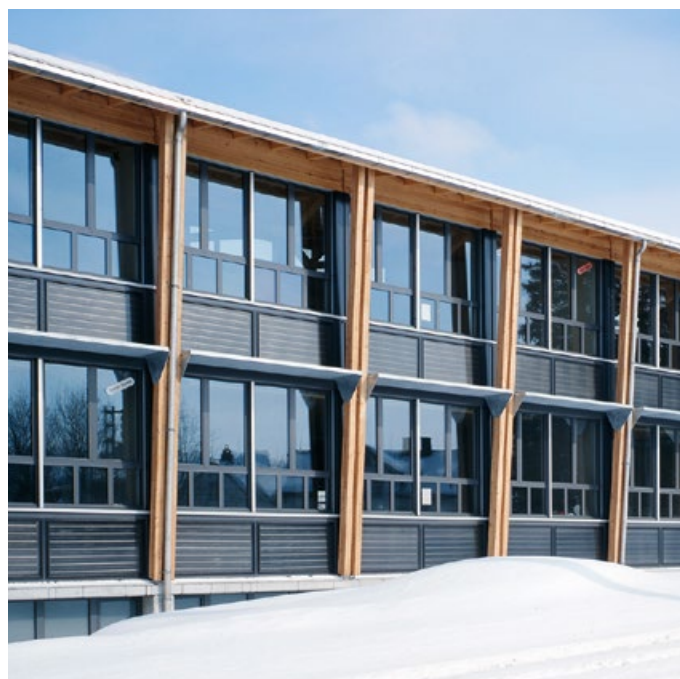
Fenêtres bois/métal, allèges avec capteurs solaires Bâtiment scolaire, Gais
