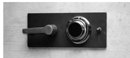
Serrure à coffre-fort: permet de transformer un abri de protection civile en une chambre forte.
